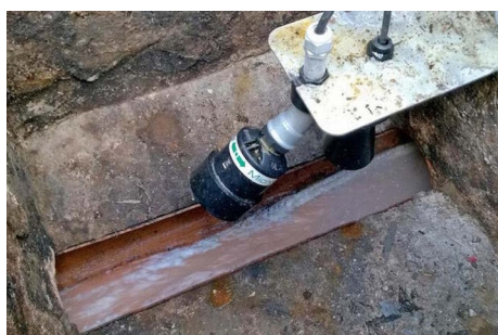
Aplicación en red de alcantarillado
