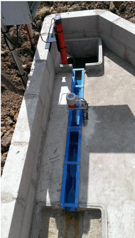
Ejemplo de montaje con medición de nivel/caudal y pH
